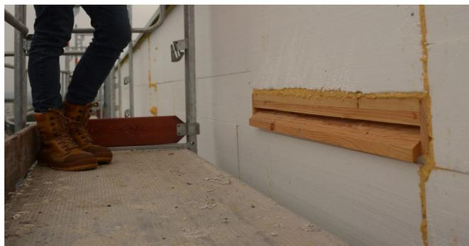
Nichoir en place à 25m de hauteur avec pose de l'enduit
